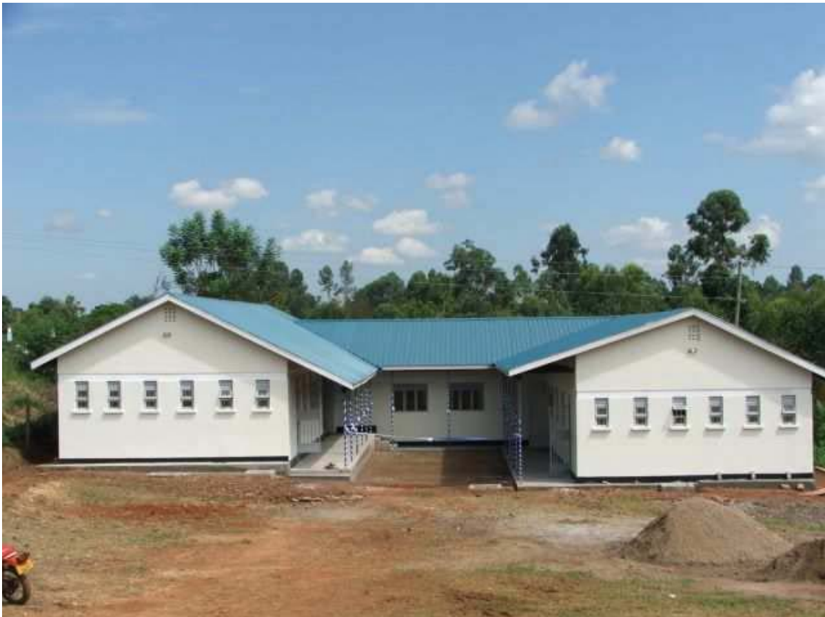
Foto: het meisjeshostel is gereed
