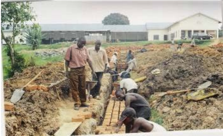
Foto: de fundamenteën voor de hostel worden gelegd
